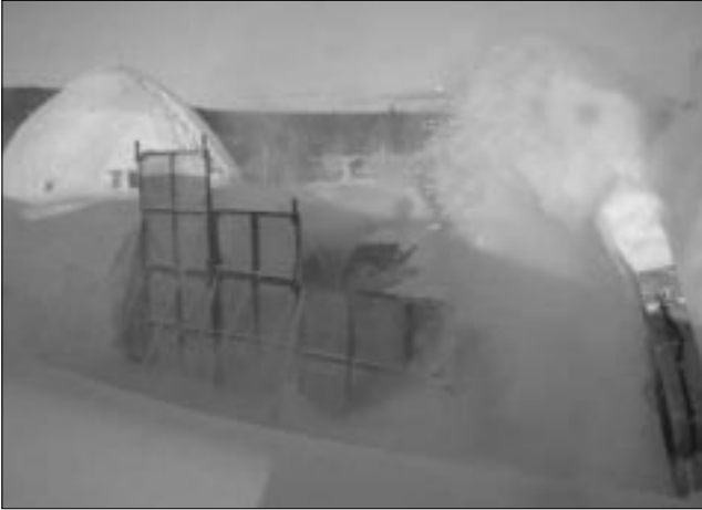
FIGUUR 3: SNEEUW WORDT OP DE MALLEN GESPOTEN.
